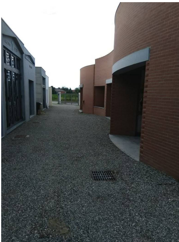
Accesso carraio all'area di cantiere con vista del loculario tipologico
