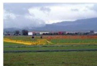
ALLESTIMENTO DELL'AREA DI CANTIERE
