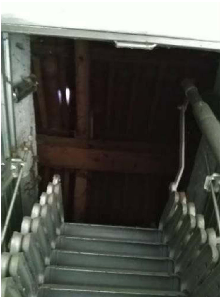
Botola di accesso al sottotetto
