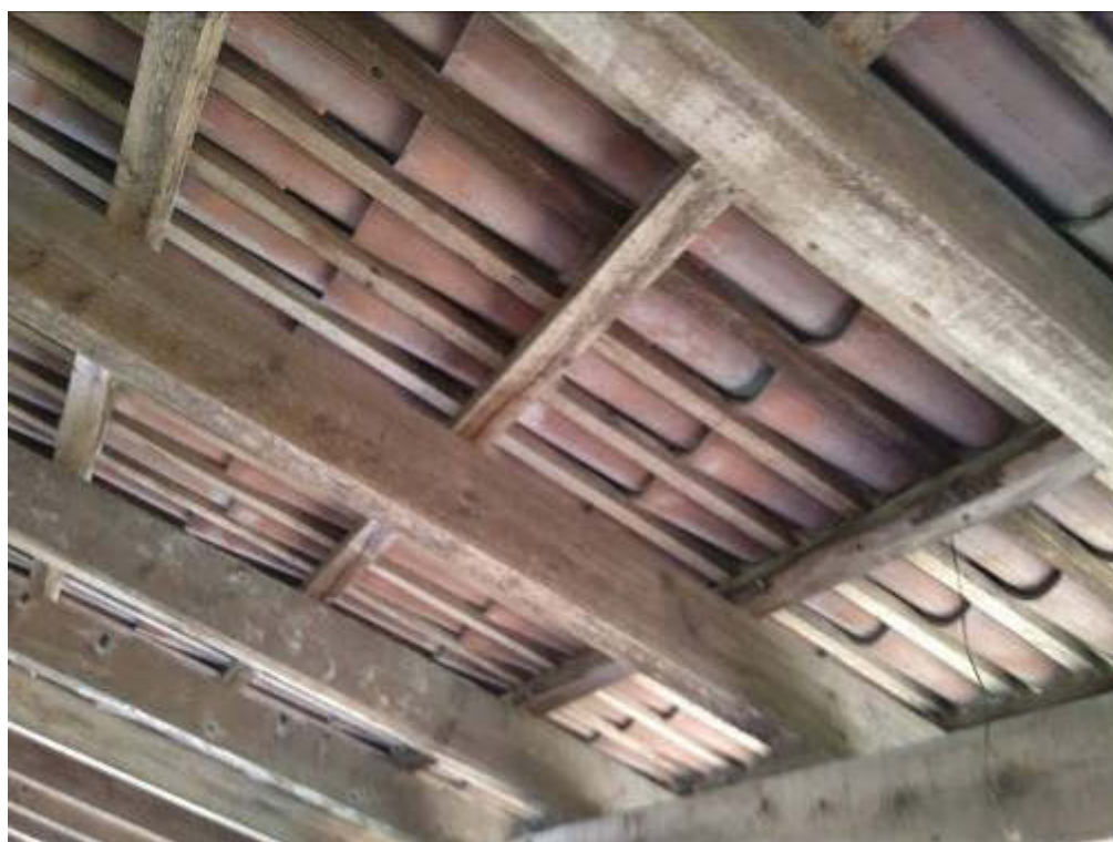
Struttura della copertura
