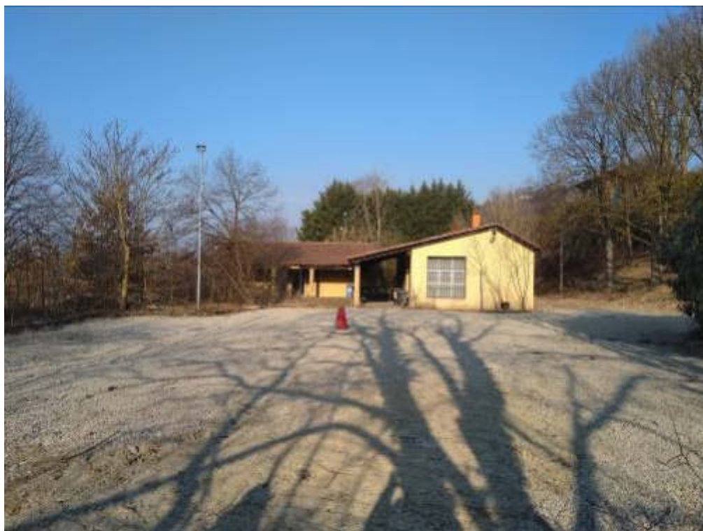
Vista dei fabbricati – lato ingresso
