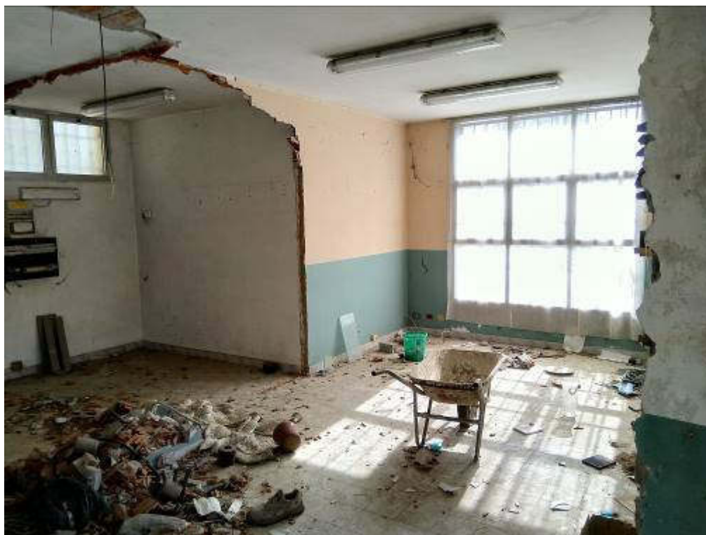
Ingresso fabbricato A – sala a disposizione
